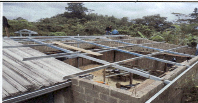
Foto1: Estructura de techo: En proceso de colocacion de estructura de laminas .
