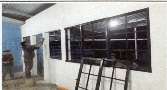
Foto 3:Ventanas y Puertas; En proceso de colocacion de puerta y ventanas.
