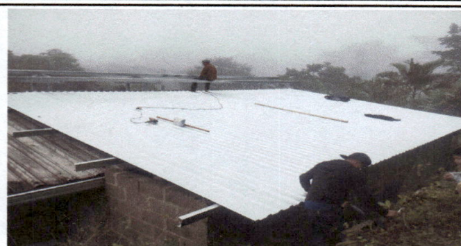
Foto 2: Cubierta de Lamina; En proceso de colocacion de lamina troquelada calibre 26
