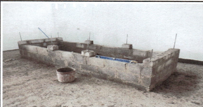
Foto 2: Poyeton; En proceso de fabricación del poyeton de cocina.
