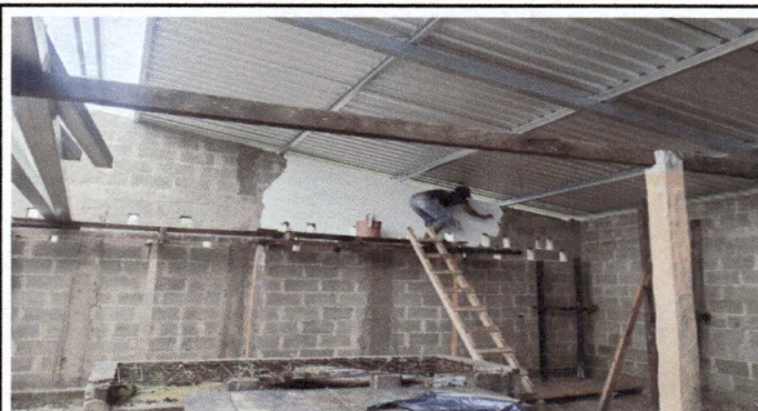
Foto 4: Cernido en paredes; en proceso de cernillado de paredes de cocina
