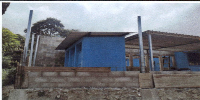
Foto 1: Muro Perimetral; En proceso, ya se colocó blocks ya solo falta la electromalla.
